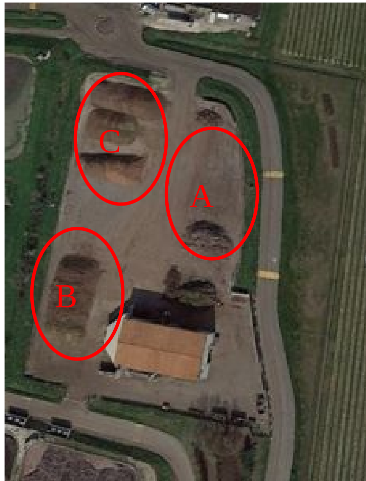
Figura 1: Impianto di tritovagliatura e relativi piazzali
